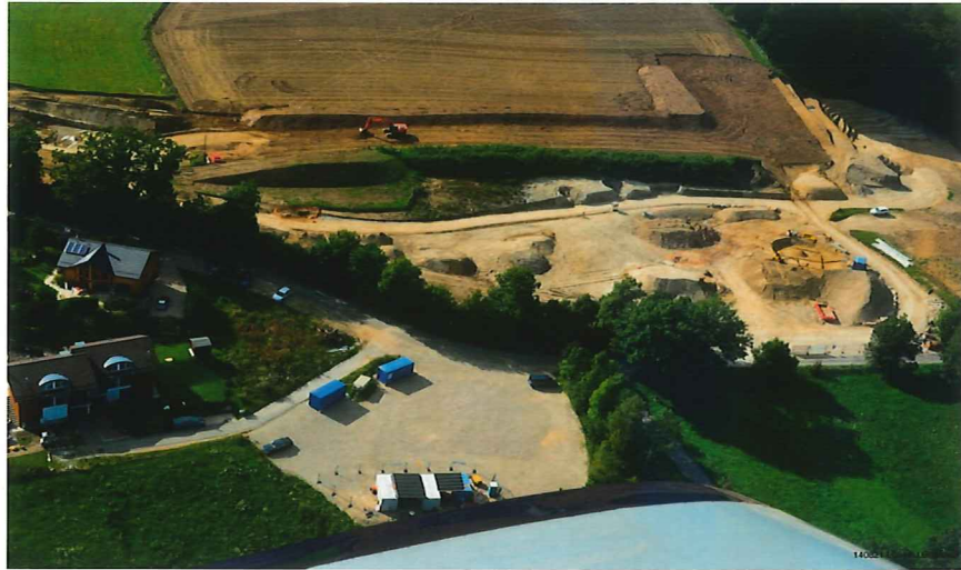
Photo aérienne du chantier prise le 21 août 2014 par Jean Bourdieu et Patrick Schelling
